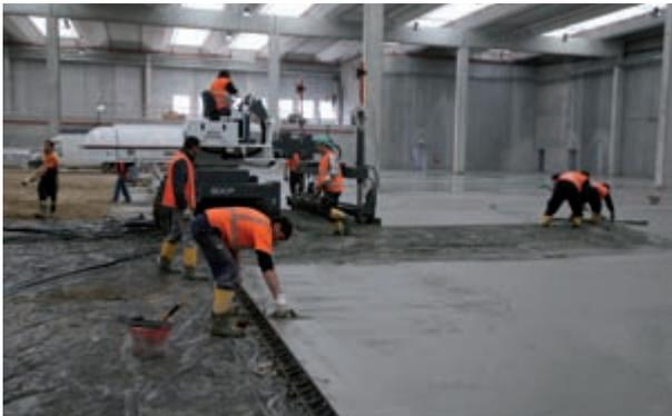
FÌBREO è stato accuratamente messo a punto per ottenere l'ideale omogeneizzazione tra i suoi diversi componenti. Particolare attenzione è stata rivolta alla compatibilità chimica e all'aderenza tra fibre e matrice cementizia per impedire lo sfilamento delle fibre stesse e preservarne la resistenza alle tensioni interne causa delle fessurazioni.
