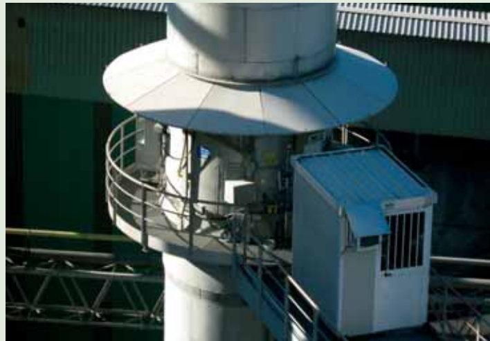
Veduta d'insieme e focus strumenti controllo emissioni a camino
