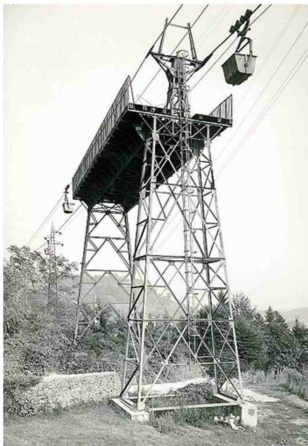
Una storica immagine della teleferica della cementeria
