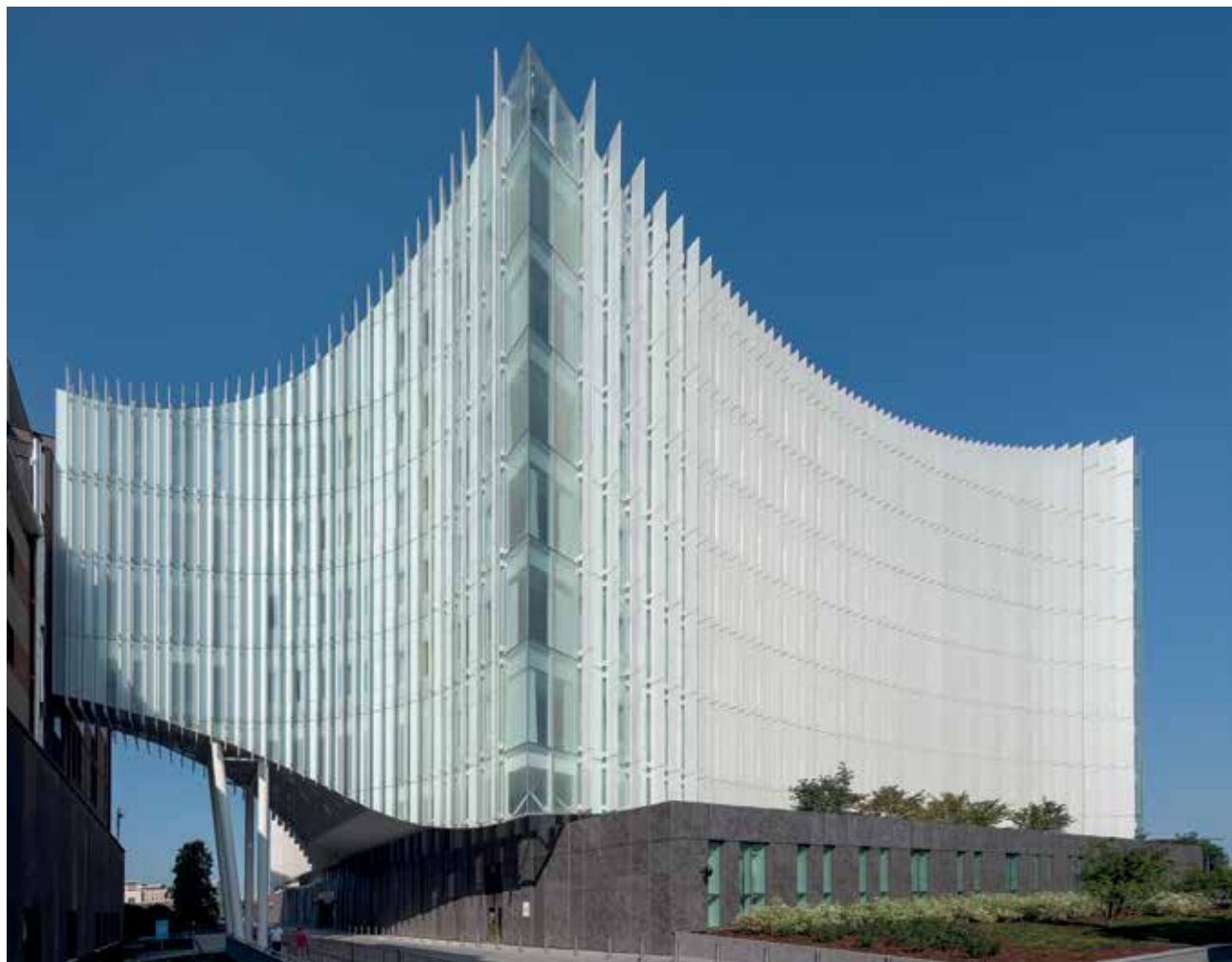
Nella soletta che sostiene il ponte di collegamento tra la nuova struttura e quella esistente, il calcestruzzo Holcim è stato pompato per 200 metri in orizzontale (ph. Duccio Malagamba, ©MC A).
