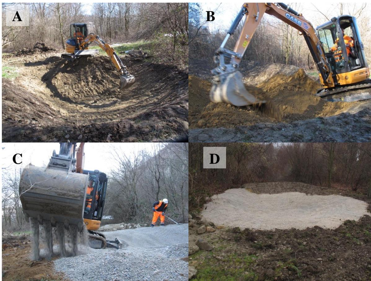
**Figura 1.9.** Realizzazione delle pozze. A : fase di scavo della pozza; B: spargimento dell'argilla per l'impermeabilizzazione; C: spargimento del ghiaietto di copertura; D: realizzazione finale.
