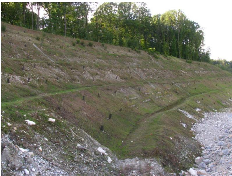
**Figura 1.6.** Sfalcio delle scarpate per il contenimento delle specie esotiche.
