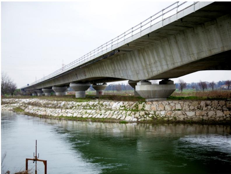
In termini di cemento per i consolidamenti, i pali e le iniezioni è stato fornito principalmente pozzolanico, di cui il 90% di CEM IV/A 32,5 R. Il cemento pozzolanico, utilizzato per quanto sopra citato, è risaputo essere un prodotto eco – efficiente perché a minor contenuto di clinker. Tale cemento è inoltre certificato LH, in quanto per la sua composizione chimica e in conformità alle normative di riferimento ottiene un calore di idratazione inferiore ai 270 J/g. Inoltre la presenza
